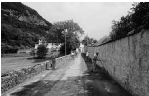
Alpini all'opera lungo il muro di cinta del convento di Vedana.
